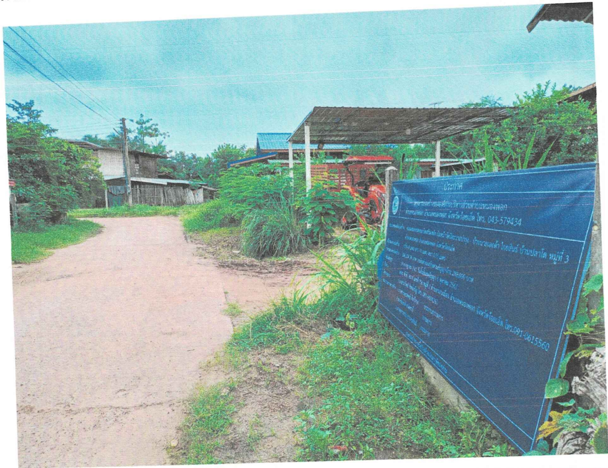
ภาพถ่ายก่อนและหลังซ่อมถนน จากวัดปิยะवासบำรุง(เมรุ) ถึงบ้านนายเอ็ดต้า ไทสินธ์ บ้านปลาโต หมู่ ๓
