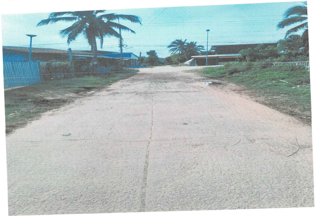
ภาพถ่ายก่อนและหลังซ่อมผิวถนนสาย รอ.ถ.๑๘๕-๐๒ (ข้างโรงเรียนบ้านปลาโต) บ้านปลาโต หมู่ ๙
